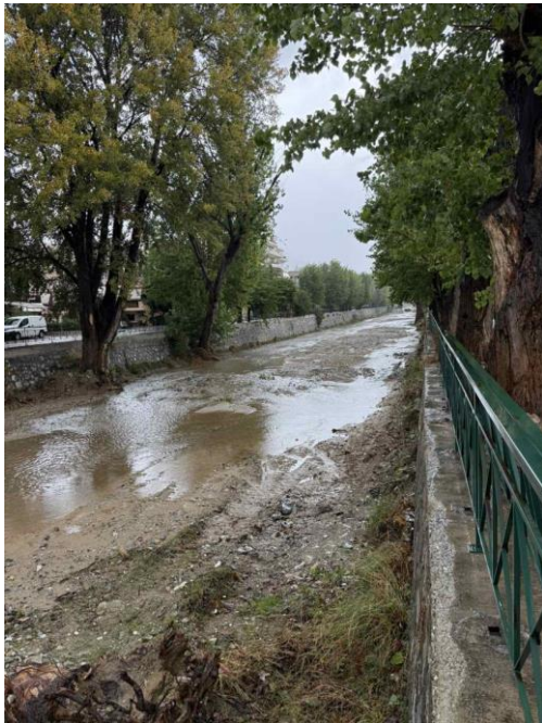
Κραυσίδωνας: ροή εντός της κοίτης, με αποθέσεις αδρανών και φερτών στον πυθμένα.
