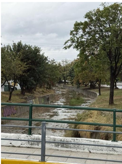
Άναυρος: ροή χαμηλής στάθμης στην κοίτη από σκυρόδεμα, με φερτά υλικά στον πυθμένα.
